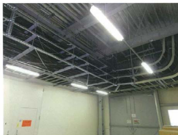
写真7 Lアングル（穴空き）による復旧
