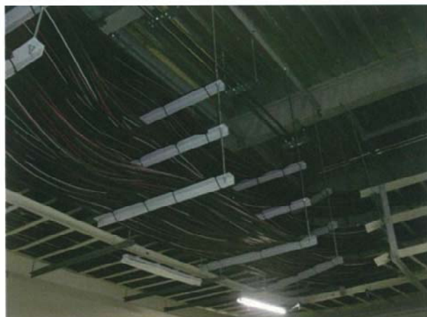
写真6 Lアングル鋼材によるケーブル吊上げ
