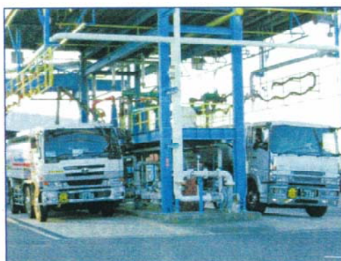
No.3 レギュラーガソリン14,000ℓ給油状況
