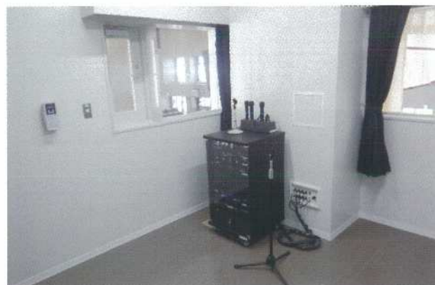
■体育館放送室
