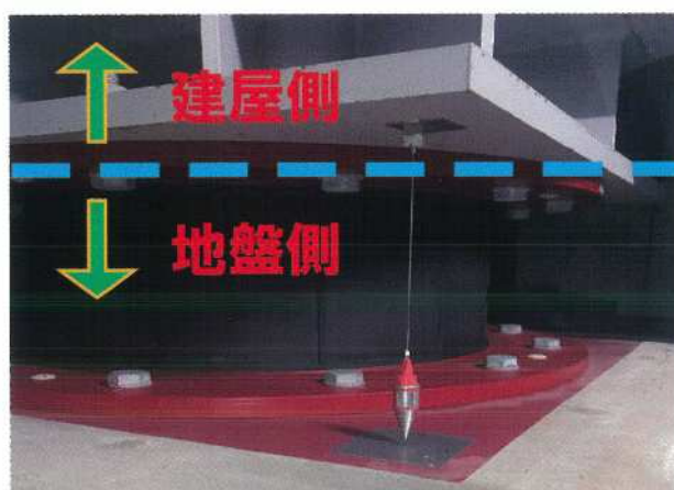
図3.免震装置（積層ゴム）の設置状況
